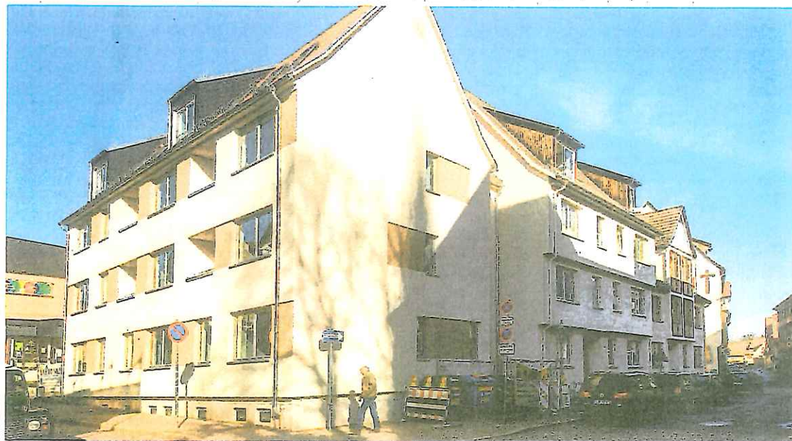
Die Arbeiten am Haus Neuendorf/Ecke Marschlinger Hof stehen vor dem Abschluss.
