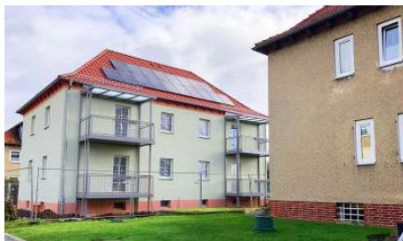
Unterscheidet sich nicht nur optisch von seinen Nachbarn aus der gleichen Bauzeit: das Haus Käthe-Kollwitz-Straße 19, das die Wowi umfassend saniert hat.
