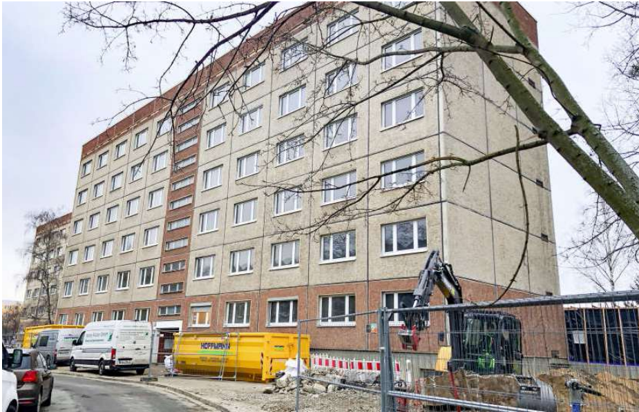
Ganz neue Wohnungen und Photovoltaik auf dem Dach: Die Wowi saniert das Haus Erlenstraße 5 umfassend.
