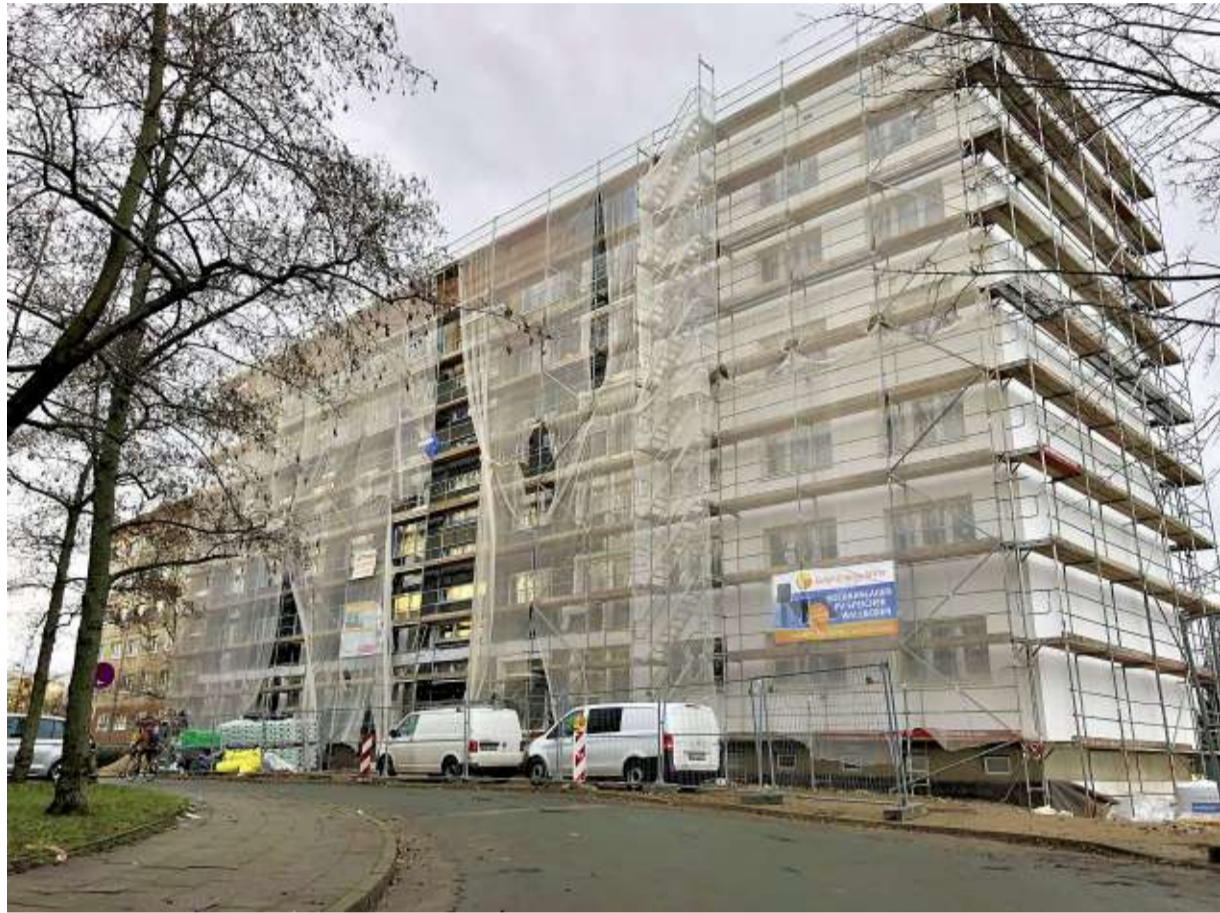
Auch in diesem Jahr das größte Investitionsvorhaben ist die Komplettsanierung des Sechsgeschossers Erlenstraße 5.
