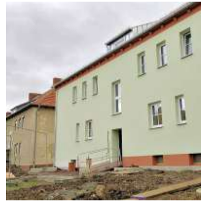
Im Februar abgeschlossen werden soll die Sanierung des Siedlungshauses Käthe-Kollwitz-Straße 23 (r.). Begonnen werden dann am Nachbarhaus Nummer 22 (l.) analoge Arbeiten. FOTOS: KORN
