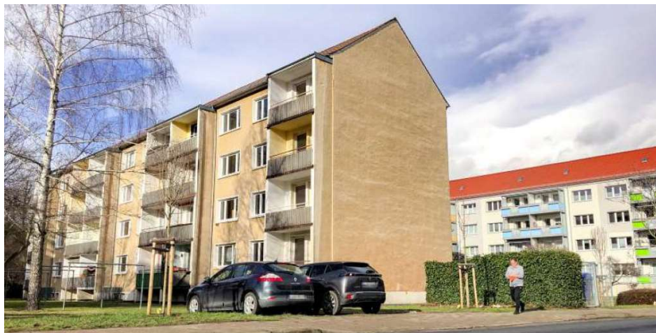
Das Mehrfamilienhaus Gartenstraße 6 bis 8 (vorn) soll saniert und umgestaltet werden – so, wie es bereits mit dem Haus Gartenstraße 9 bis 11 (hinten) erfolgt ist.
