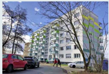
Ist in den vergangenen Jahren komplett umgebaut und – auch energetisch – saniert worden: das Haus Erlenstraße 5. FOTO: PETRA KORN
