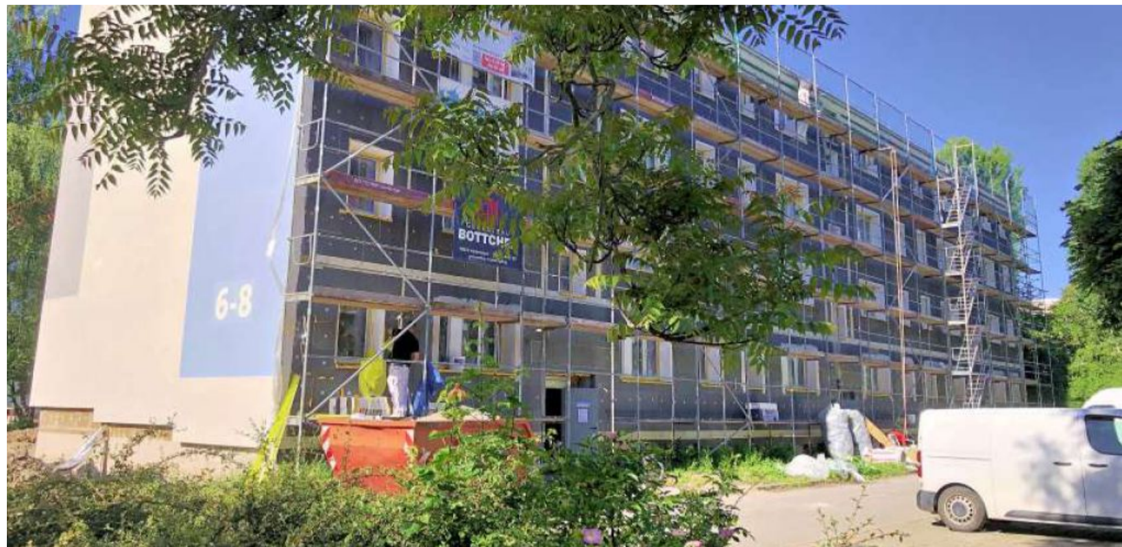
Das Wohnhaus Gartenstraße 6 bis 8 wird komplett saniert. Auf der Nordseite ist gerade ein Wärmedämmverbundsystem angebracht worden.
